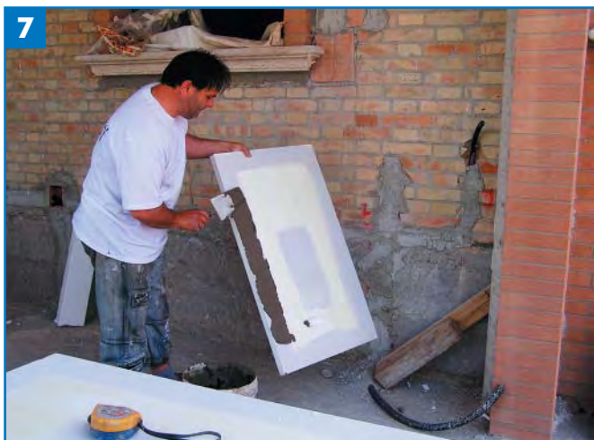
7 — ...O PUÒ ESSERE DISTRIBUITO SOLO SUL PERIMETRO DEL PANNELLO.
