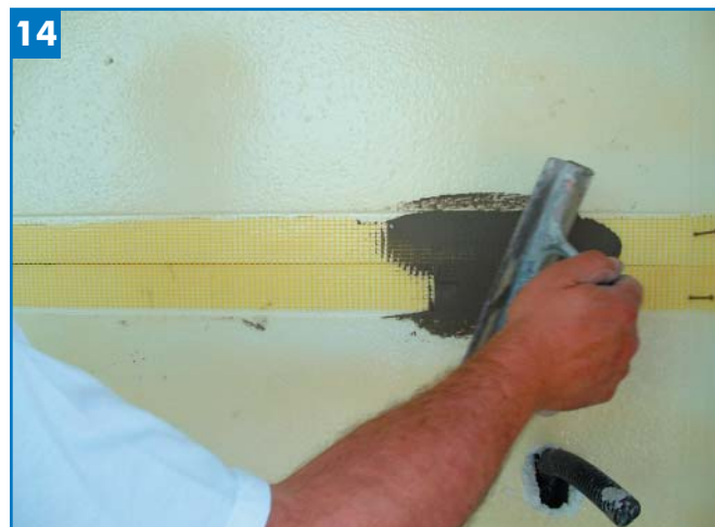
14 — POSIZIONAMENTO DELLA FASCIA DI RETE NELL'APPOSITO SCASSO.
