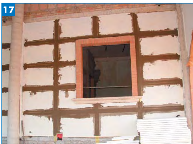
17 — LAVORO TERMINATO, PRIMA DELLA FINITURA E/O PITTURA.
