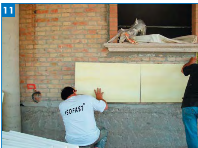
11 — POSIZIONAMENTO DEI PANNELLI SULLA MURATURA.
