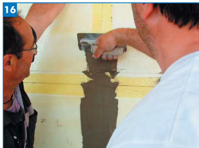
16 — CHIUSURA DELLE GIUNZIONI TRA PANNELLI.
