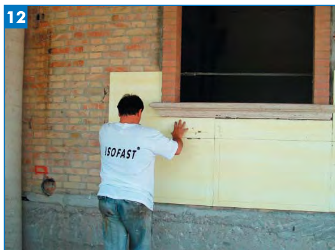
12 — POSIZIONAMENTO DEI PANNELLI RITAGLIATI.
