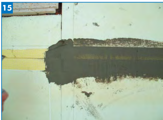
15 — BLOCCAGGIO DELLA FASCIA DI RETE CON COLLANTE.
