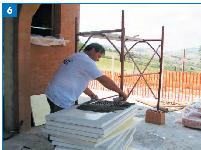
6 — IL COLLANTE PUÒ ESSERE DISTRIBUITO SULL'INTERA SUPERFICIE DEL PANNELLO...
