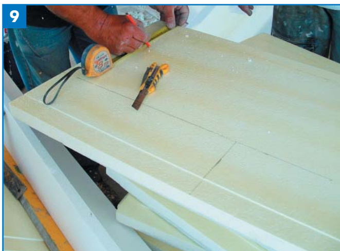
9 — IL TAGLIO PRECISO È FATTIBILE CON UN CUTTER.
